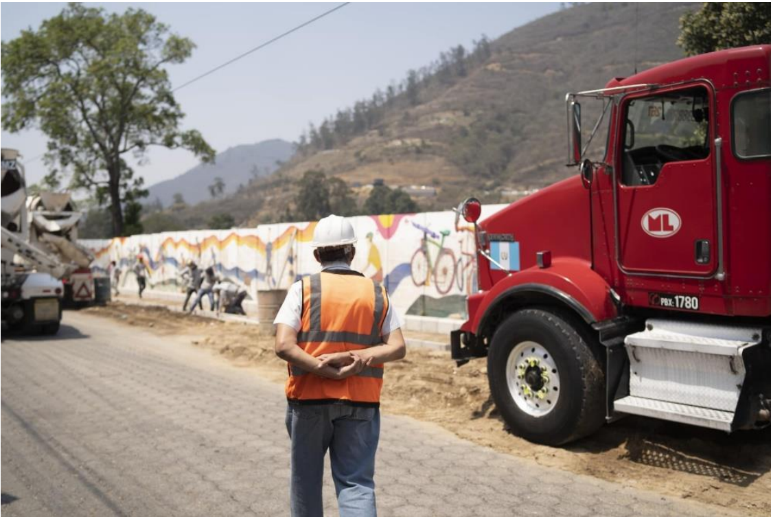
Colocación de bordillos
