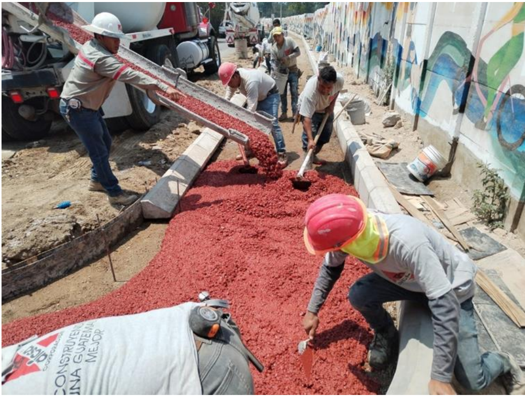
Fundición con concreto pigmentado
