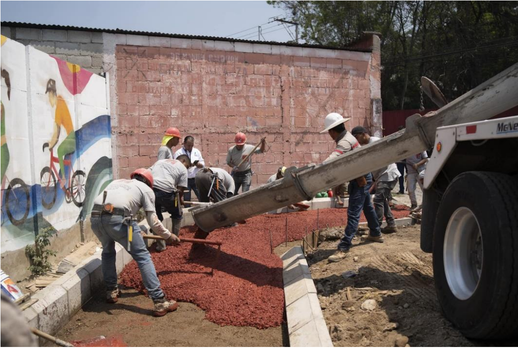
Fundición con concreto pigmentado
