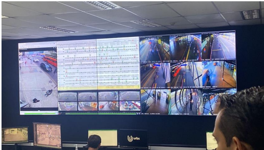
Sala de control de mando del transporte de la Ciudad de Curitiba.
