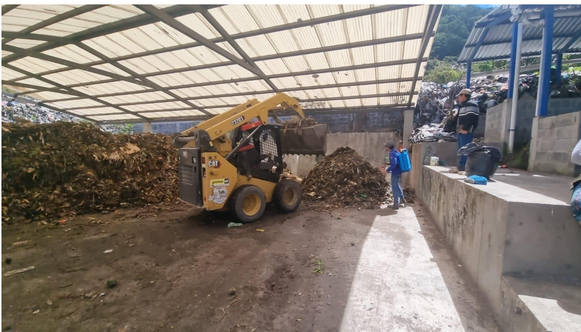
Área donde se tienen clasificada la parte orgánica con follaje, misma en la que se aplicaron las enzimas
